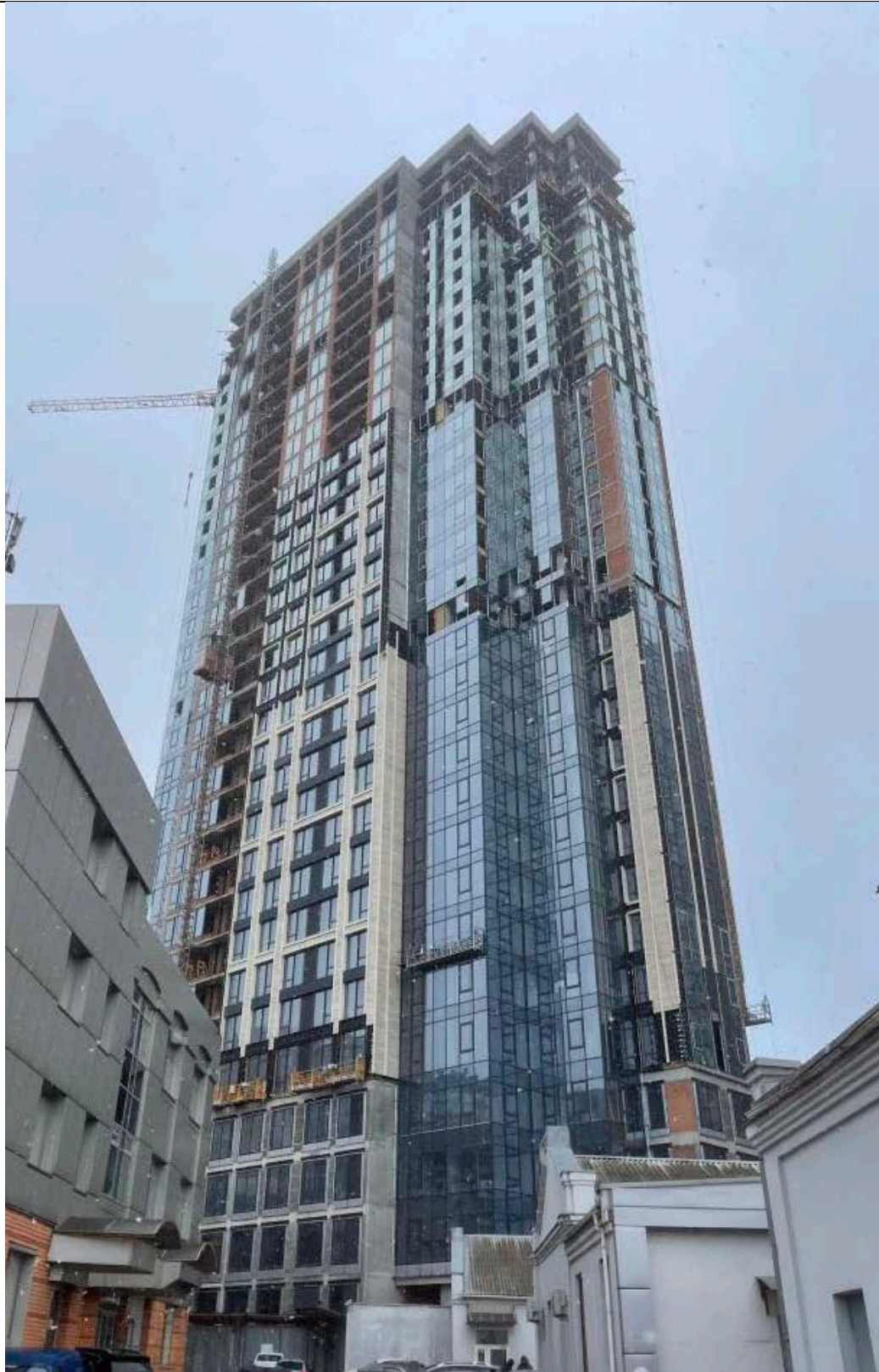
Фото №4 Загальний вигляд Фасад з боку вул. Казимира Малевича
