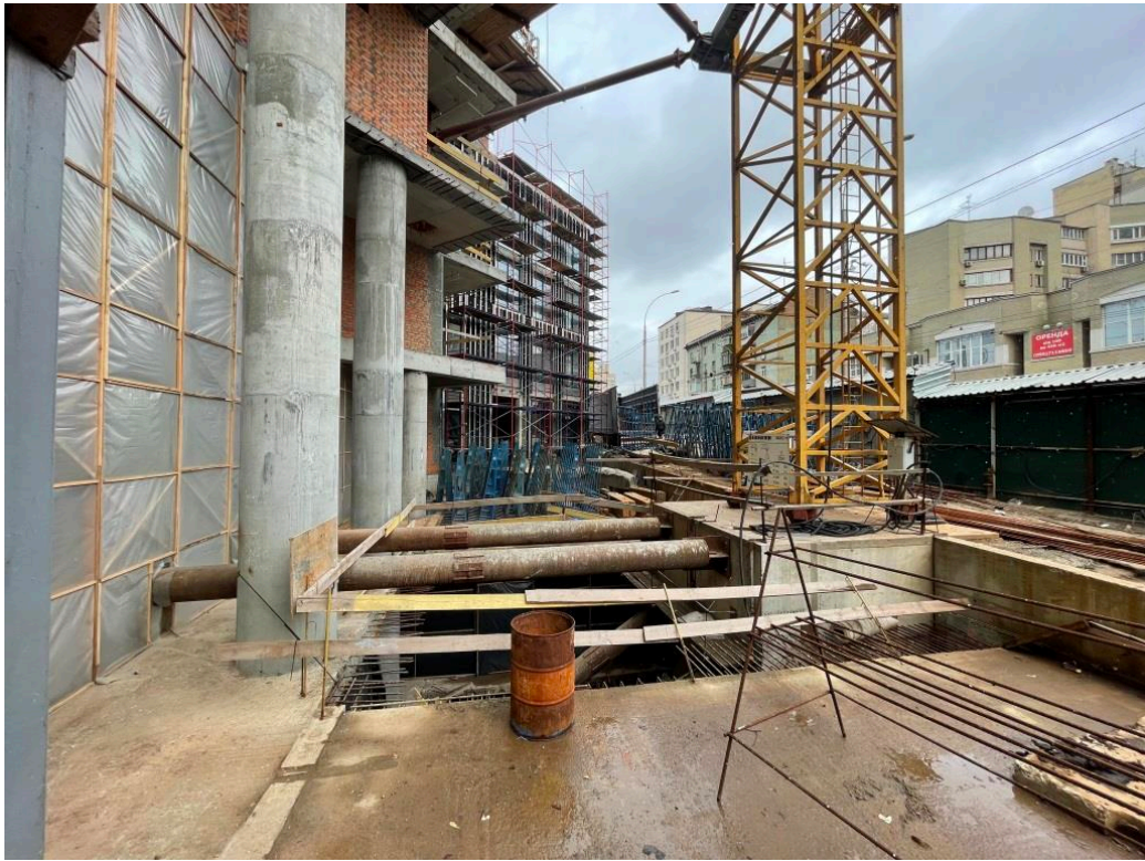
Фото №5 Загальний вигляд будівельного майданчику з боку вул. Антоновича
